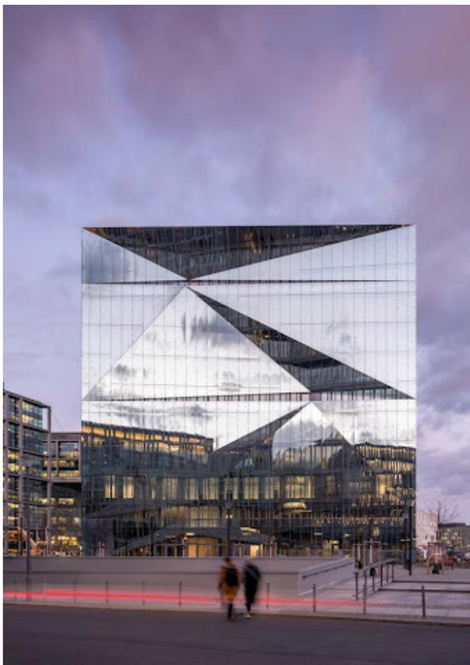
Figure 11 : Cube Berlin : Double skin façade / Façade thermique à trames décalées sous une peau de verre extérieure
